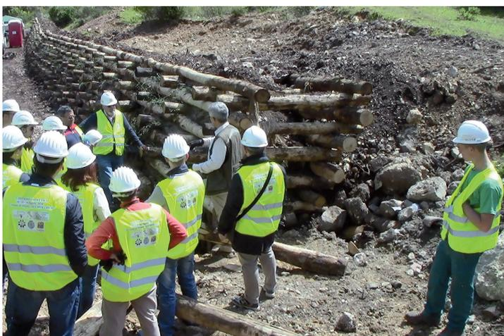
**AIPIN** - sono state effettuate sistemazioni di versanti in aree di cava dismessa, utilizzando alcune delle **principali tecniche di ingegneria naturalistica adottate in ambiente mediterraneo nel recupero dei siti degradati**, quali: palificata viva a doppia parete, palizzata, terra armata rinverdita.
